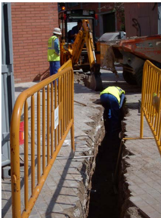
Fotografia 1: Obertura de la Rasa 1.
